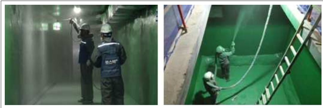
[KSC PU300 3rd 시공사진]
