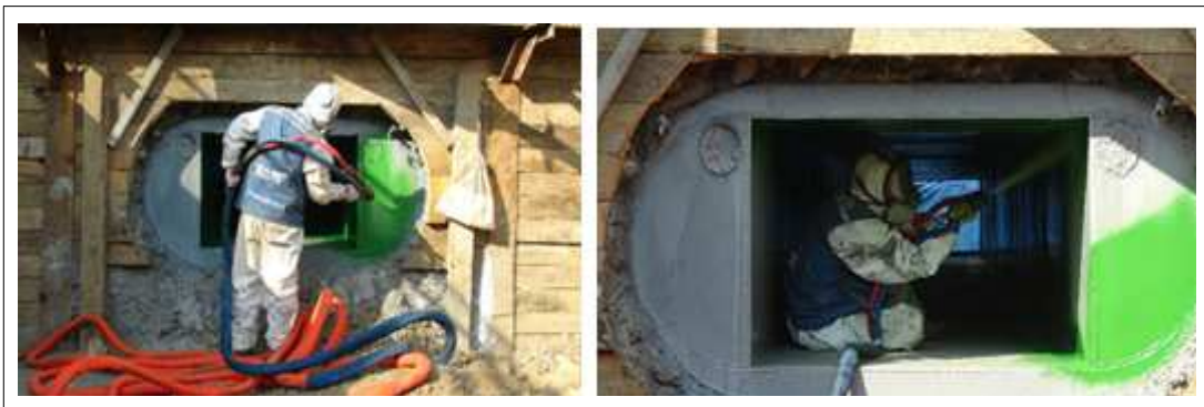
[KSC PU300 2nd 시공사진]
