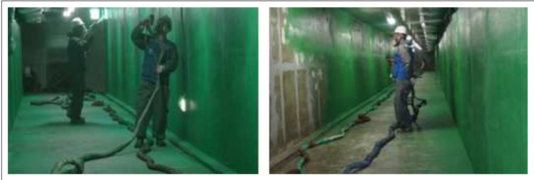
[KSC UT300 2nd 시공사진]
