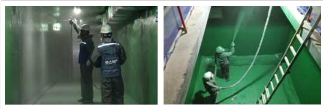
[KSC PU300 3rd 시공사진]
