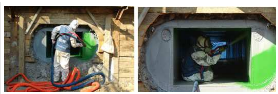
[KSC PU300 2nd 시공사진]
